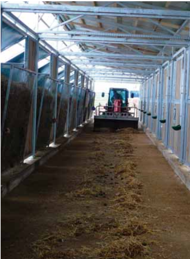
alle Trennwände sind rausgezogen
