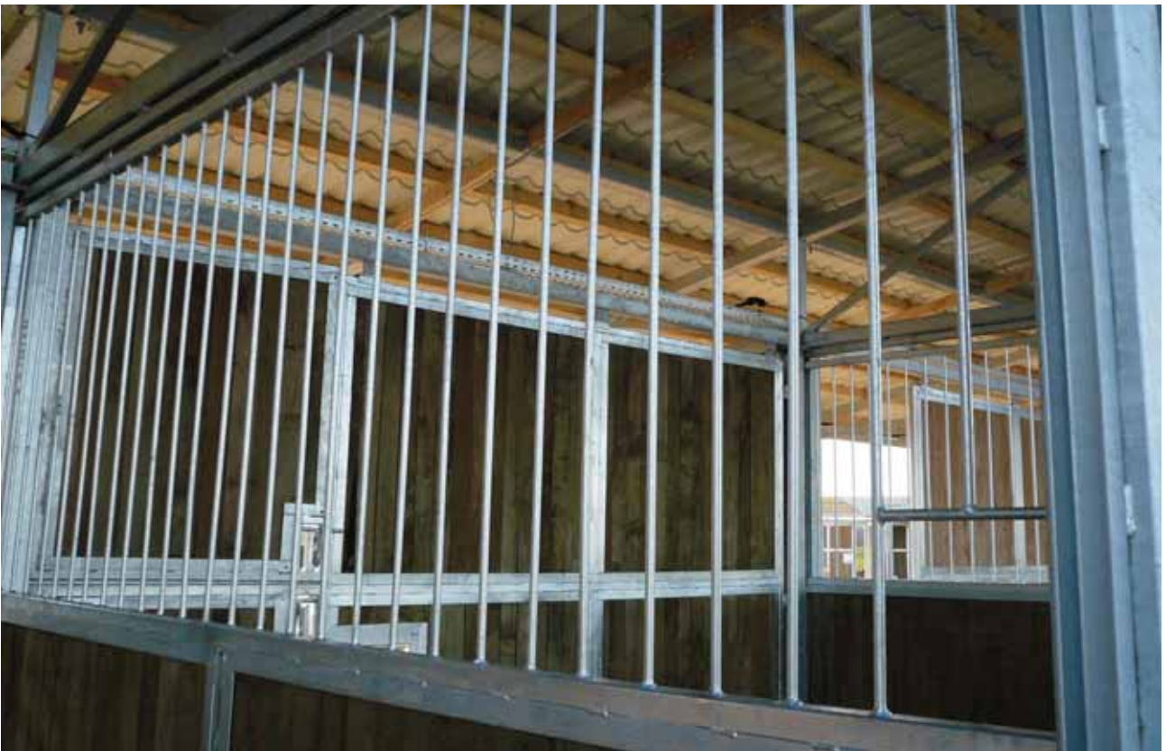
Trennwand, Ahornholz kombiniert mit Gitter
